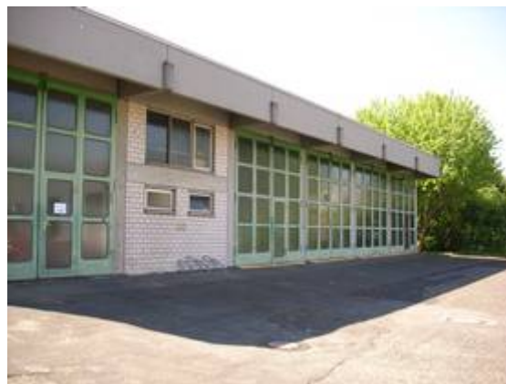
Alte Halle der FF Enkheim
