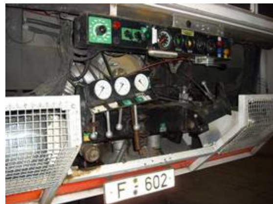
Blick in den defekten Pumpenstand
